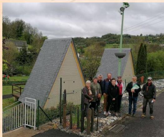
La réfection des toits des tipis s'est achevée début mai. Le bardage bois a été remplacé par une couverture en ardoise avec la mise en place d'une isolation supplémentaire. Ces travaux permettront de pérenniser ces logements tout en minimisant l'entretien et offriront un meilleur confort lors des saisons estivales de plus en plus chaudes. Le réception des travaux a eu lieu en présence de l'artisan, Mr Angelvy, de Mr Russery maître d'œuvre, et de la commission bâtiments.
